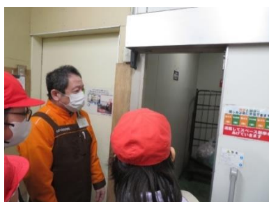
ゴミを置く部屋。生ごみが腐らないように涼しくしています。
